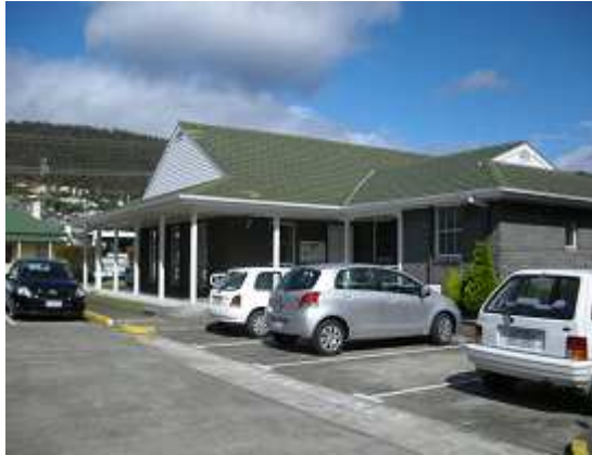
共有スペース ホール内 外観
